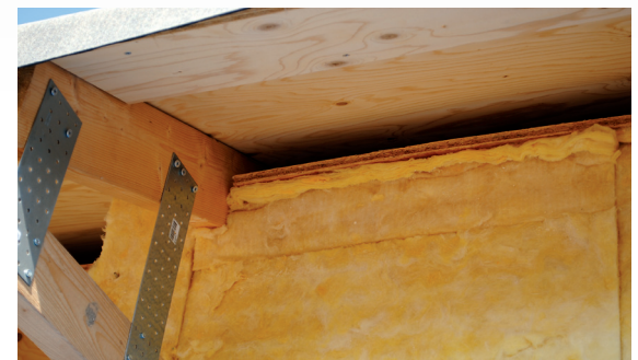
Andet lag er monteret med mineraluldslaget udad. PIR pladen fungerer her som isolering og vindbræt.
