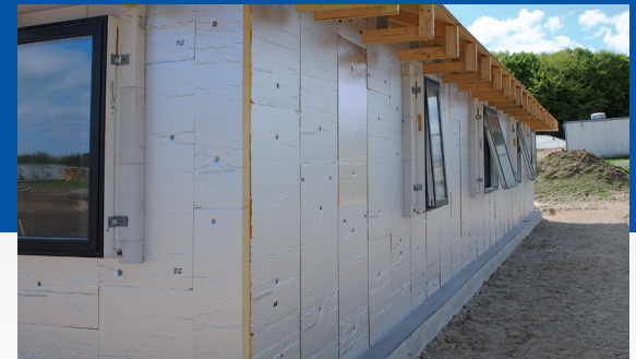
Første lag TITAN SLIMLINE + er monteret med mineraluldslaget ind mod indvendig murflange.
